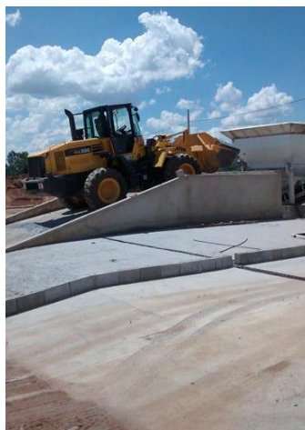
Figura 2. Balança de Agregados
