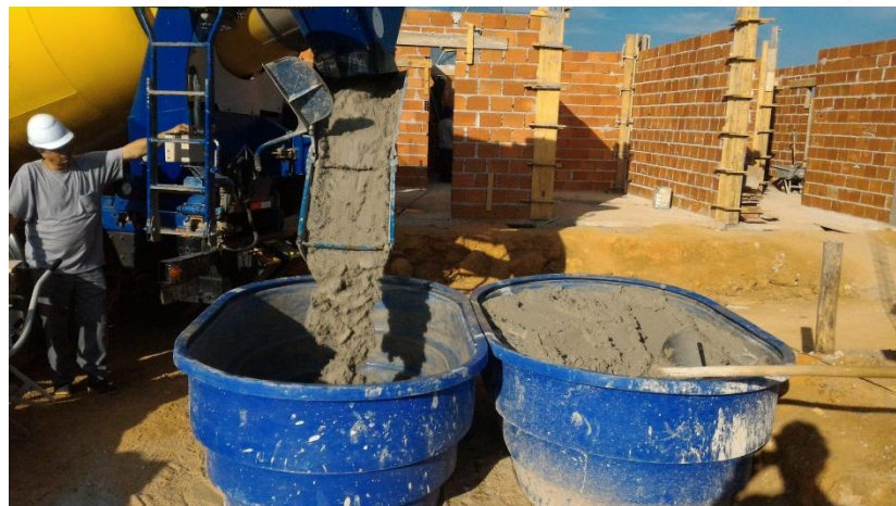
FIGURA 6 - Recebimento e armazenamento da argamassa estabilizada
