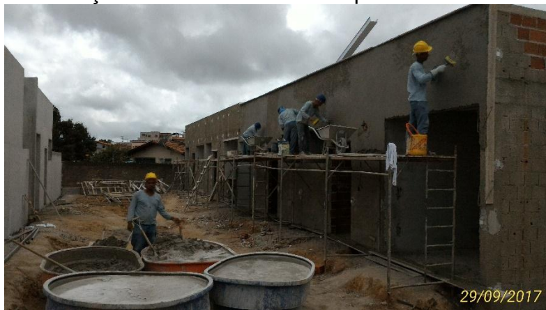
FIGURA 5: Execução do reboco na fachada para acabamento em pintura.
