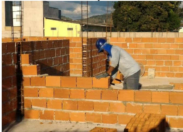
FIGURA 1: Execução de alvenaria
