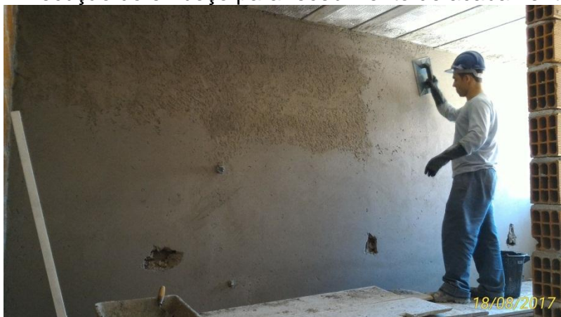
FIGURA 4: Execução do emboço para recebimento de acabamento cerâmico.
