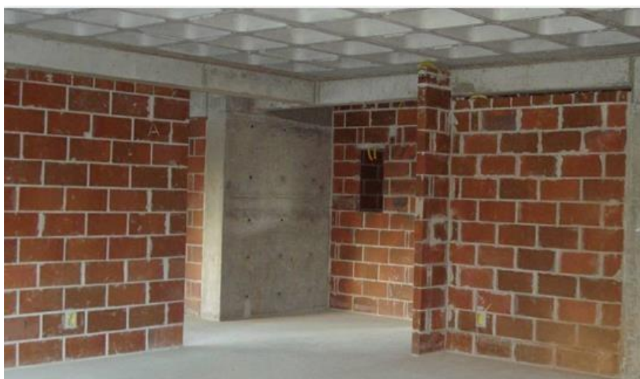
Figura 1 – Vedação de edifício em alvenaria.
