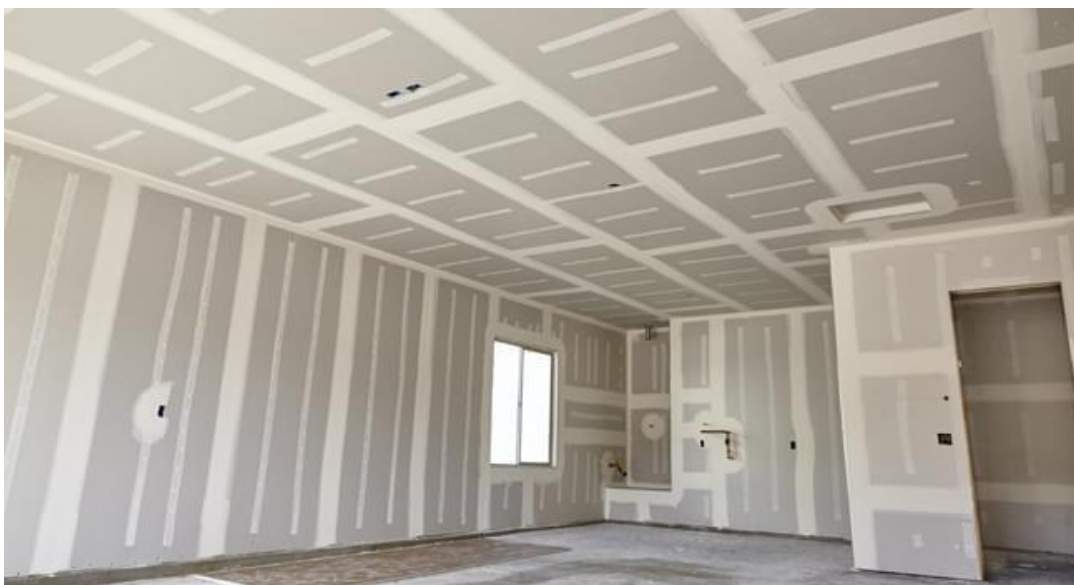
Figura 4 – Construção em drywall.
