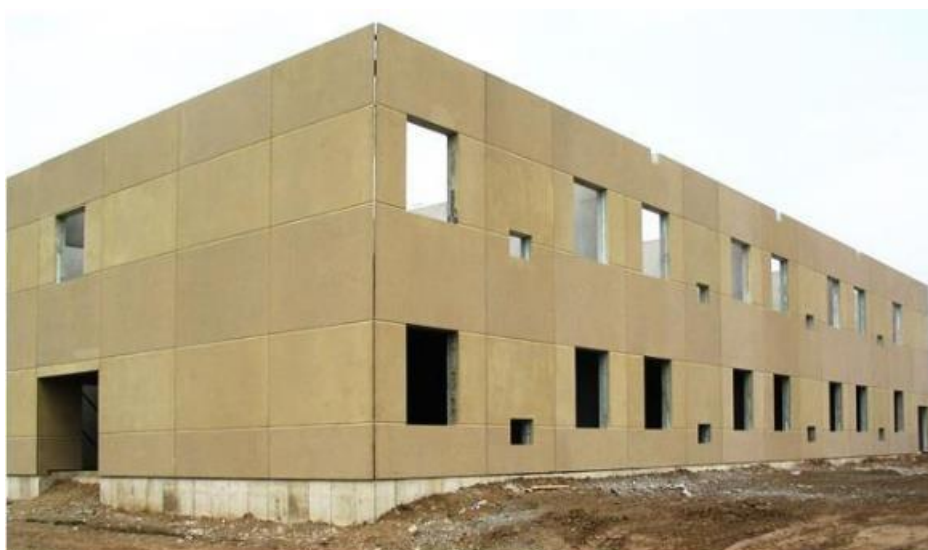
Figura 2 – Escola em Brantford em painéis de concreto, Canadá.
