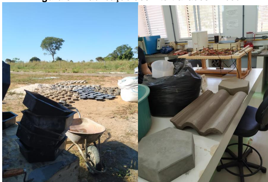
Figura 3 – Fabricação dos intertravados in loco
